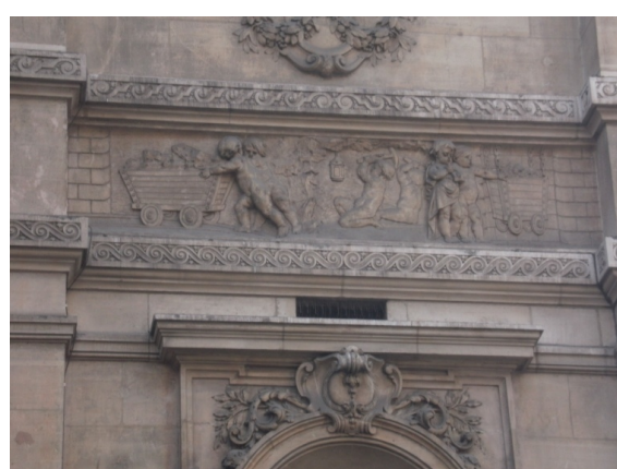
Les travaux de la mine
